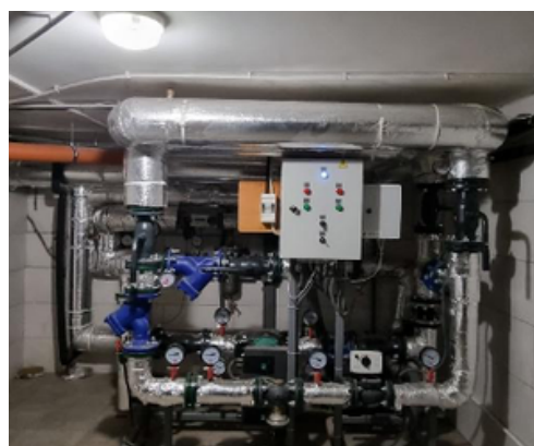
Рис. 6 – Автоматизований тепловий пункт, що може бути інтегрований в систему моніторингу
