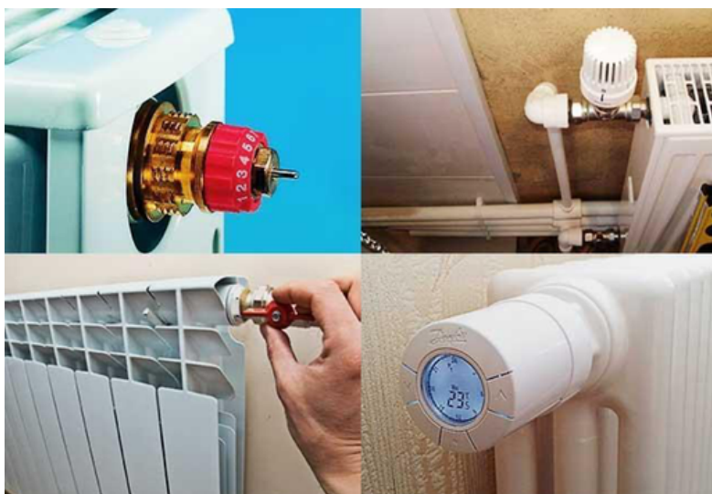
Рис. 12. Терморегулятори на радіаторах
