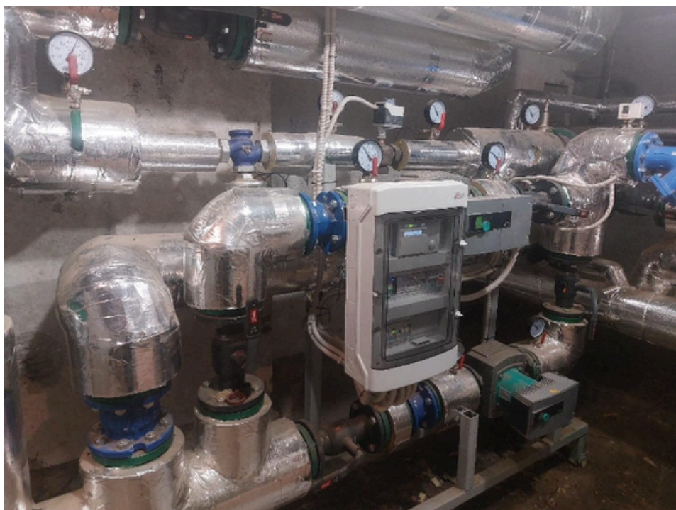
Рис. 6 Індивідуальний тепловий пункт (регулюючі клапани)
