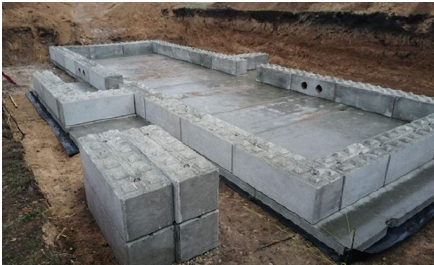
Рис. 8. Фотокопії процесу монтажу укриття
